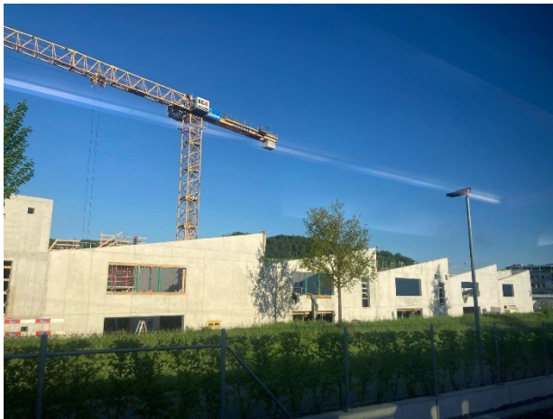
Abbildung 4: Das sich im Bau befindliche Betriebsgebäude der Stiftung Terra Vecchia in Worb BE.
